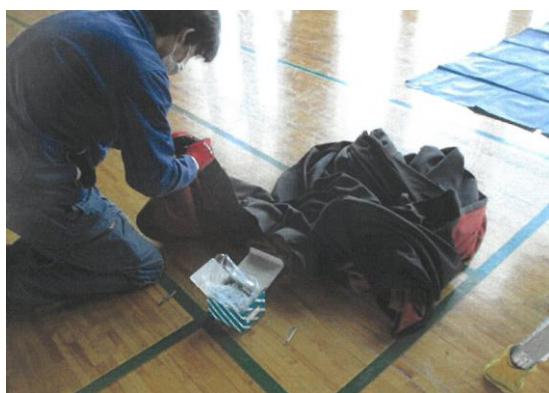
既存の暗幕へフックを取付け
