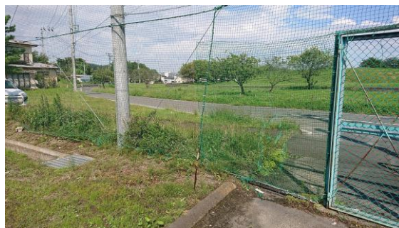
補強され穴がふさがった防球ネット
